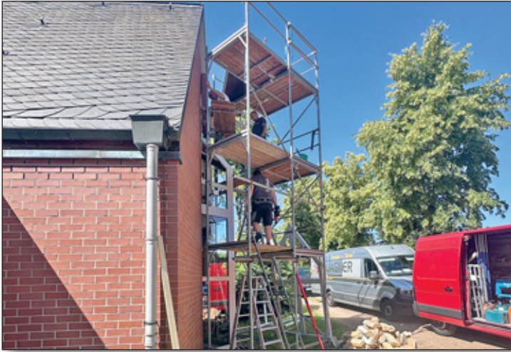
In der Trauerhalle wurden verschlissene Fenster durch neue Fenster ersetzt.
